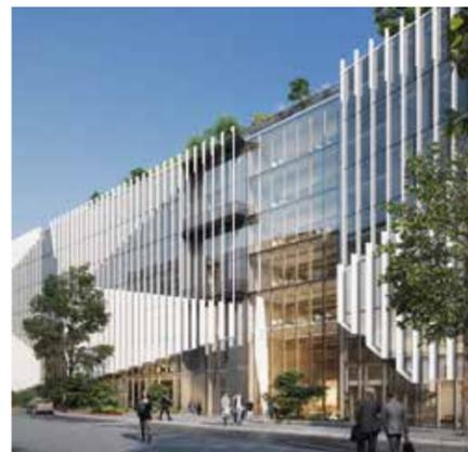
Prototypes de parement de façade en résine et fibre de verre développés pour le projet de l'immeuble Shift, Arte-Charpentier architectes.
