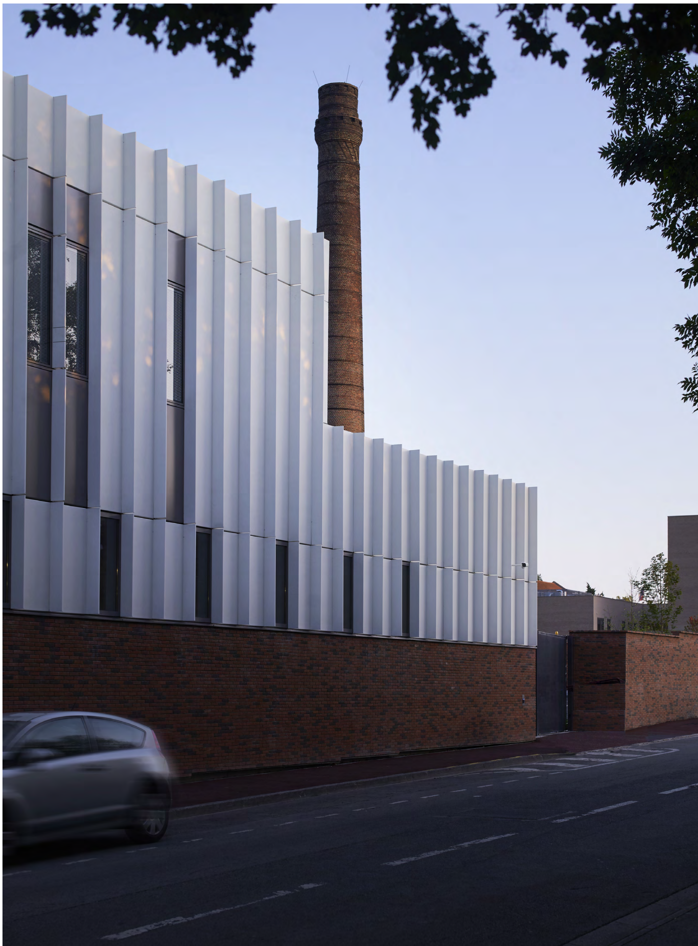
_ La cheminée conservée de l'usine voisine.
