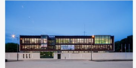
COMMISSARIAT DE POLICE À PROVINS 2010 Maître d'ouvrage : Ministère de l'Intérieur / Photographes : Luc Boegly
