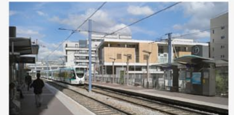
MAISON DE LA PETITE ENFANCE À ISSY-LES-MOULINEAUX 2006 Maître d'ouvrage : Ville d'Issy-les-Moulineaux / Photographes : Luc Boegly
