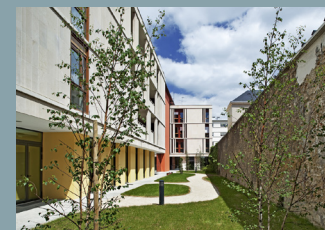
EHPAD Centre Hospitalier Richaud MO : Centre Hospitalier de Versailles 6 300 m 2 | 9,5 M€ | 2010
