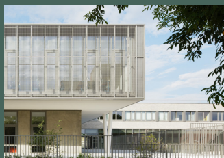
Collège Marcel Pagnol à Rueil-Malmaison MO : Département des Hauts-de-Seine | 7 600 m² | 22,3 M€ | 2019
